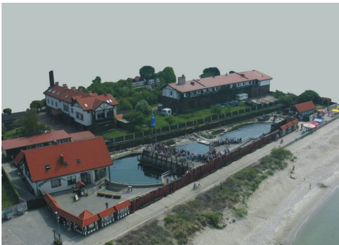
Foto. Trzy główne obiekty infrastruktury Stacji Morskiej IOUG w Helu. Na pierwszym planie tzw. fokarium - budynek ekspozycji edukacyjnych z salą dydaktyczną oraz baseny hodowlane. W tle, z lewej strony baza socjalna placówki, z prawej budynek laboratoryjno-administracyjny (fot. Dariusz Bógdał).
